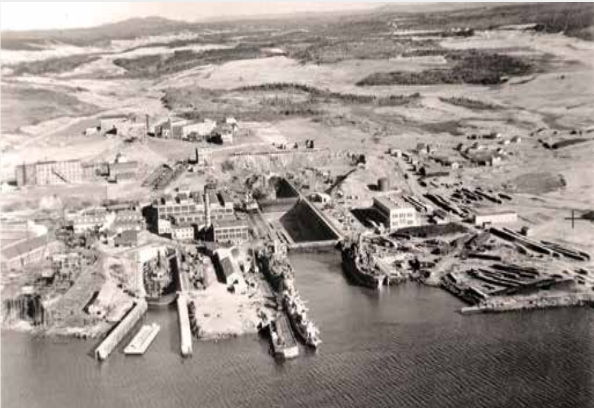
Le chantier naval ( dry dock ) de Saint-Jean en 1942 (Photo: Bibliothèque et archives nationales du Canada)
