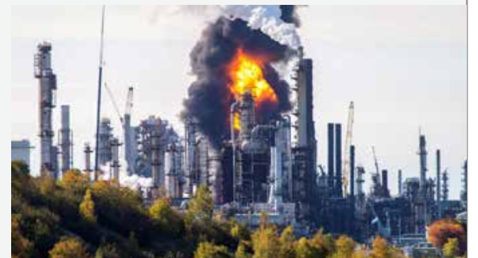
Explosion à la raffinerie de Saint-Jean en 2018. (Photo: Michael Hawkins)
