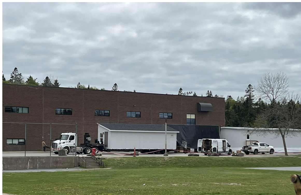
Installation d'une quatrième classe mobile au Centre scolaire Samuel-de-Champlain. Crédit: Gracieuseté.
