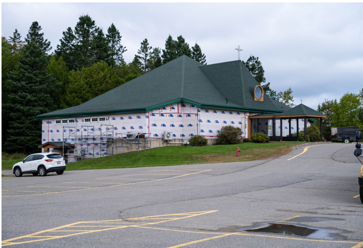
Le revêtement extérieur de l'église a été enlevé pour des travaux d'amélioration de l'isolation. Crédit: Jonathan Poirier.
