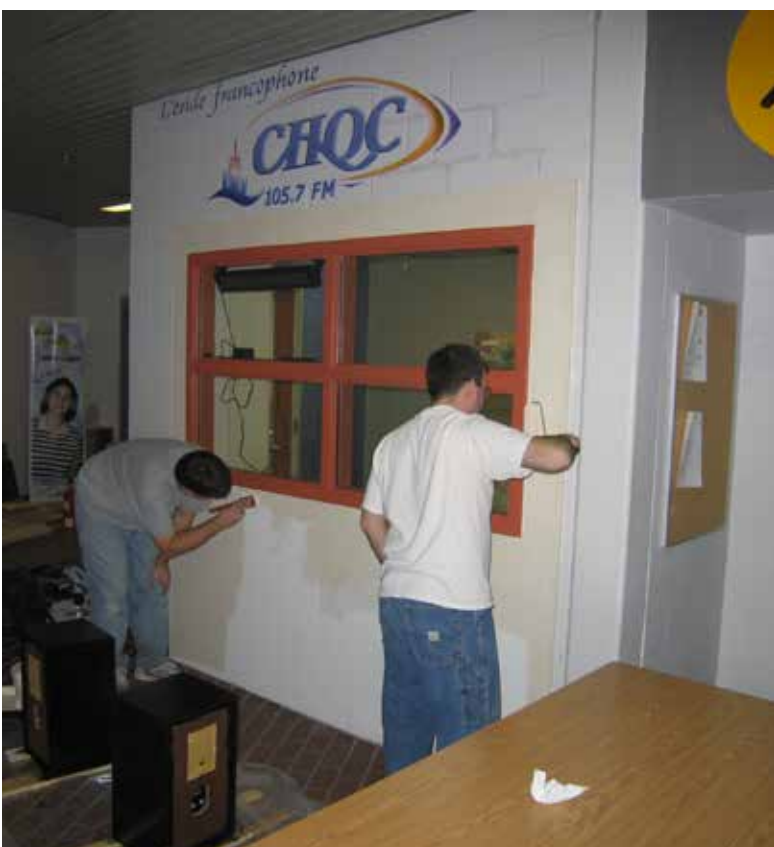
La construction du local de la radio. Crédit: Gracieuseté.
