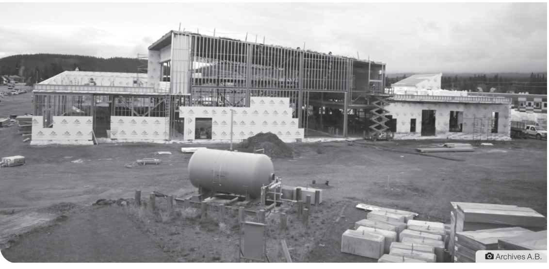
Construction du Centre scolaire secondaire communautaire Paul-Émile Mercier.
