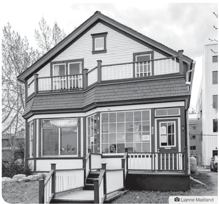
La Maison Captain Martin, située sur la 3 e Avenue, a besoin de rénovations.
