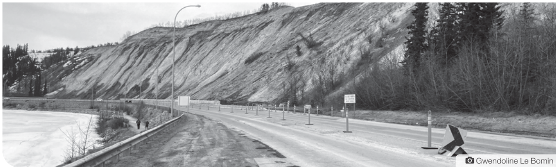
Fin mars, les équipes de la Ville ont déplacé les voies de circulation de la voie Robert Service pour les éloigner du pied de l'escarpement. Des panneaux numériques et des blocs sont en place aux deux extrémités de la zone, au cas où la route devrait être fermée.
