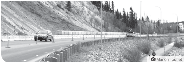
Pour protéger la route des glissements de terrain, des blocs d'écluse ont été installés le long d'une partie de l'escarpement de la voie Robert Service.
