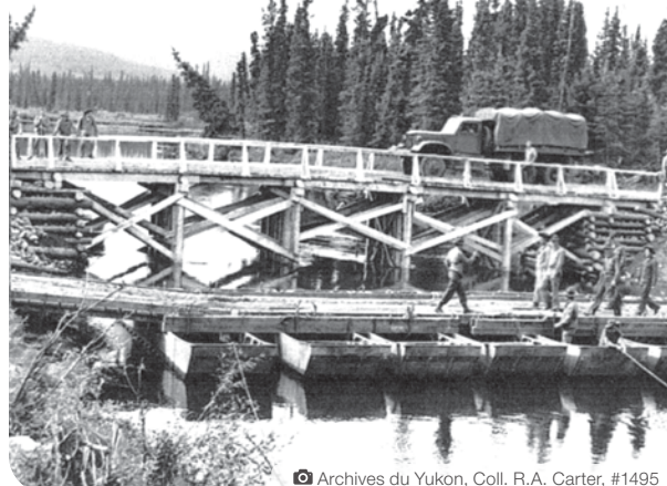
Construction de la route de l'Alaska, longtemps nommée Alcan (pour « Alaska-Canada »).
