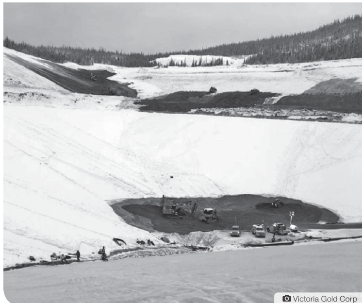
Installation des roches en tas avant le procédé de lixiviation au cyanure.
