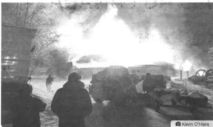
Les flammes ont dévasté l'entièreté du bâtiment historique.
