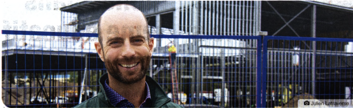
Marc Champagne devant la construction de la fameuse école secondaire. Les travaux pour compléter l'établissement finiront au courant de l'été 2020.
