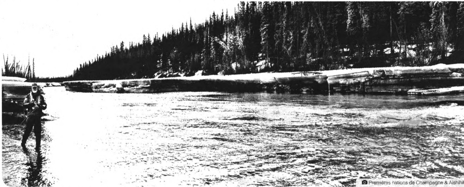
Des couches de glace et de sédiments d'une profondeur de plus de deux mètres sur la rivière Aishihik, en aval de l'installation hydroélectrique, créent des conditions infranchissables pour les personnes et les animaux.
