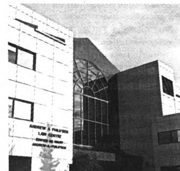
Des travaux d'amélioration ont été réalisés dans les cellules du Palais de justice de Whitehorse.
