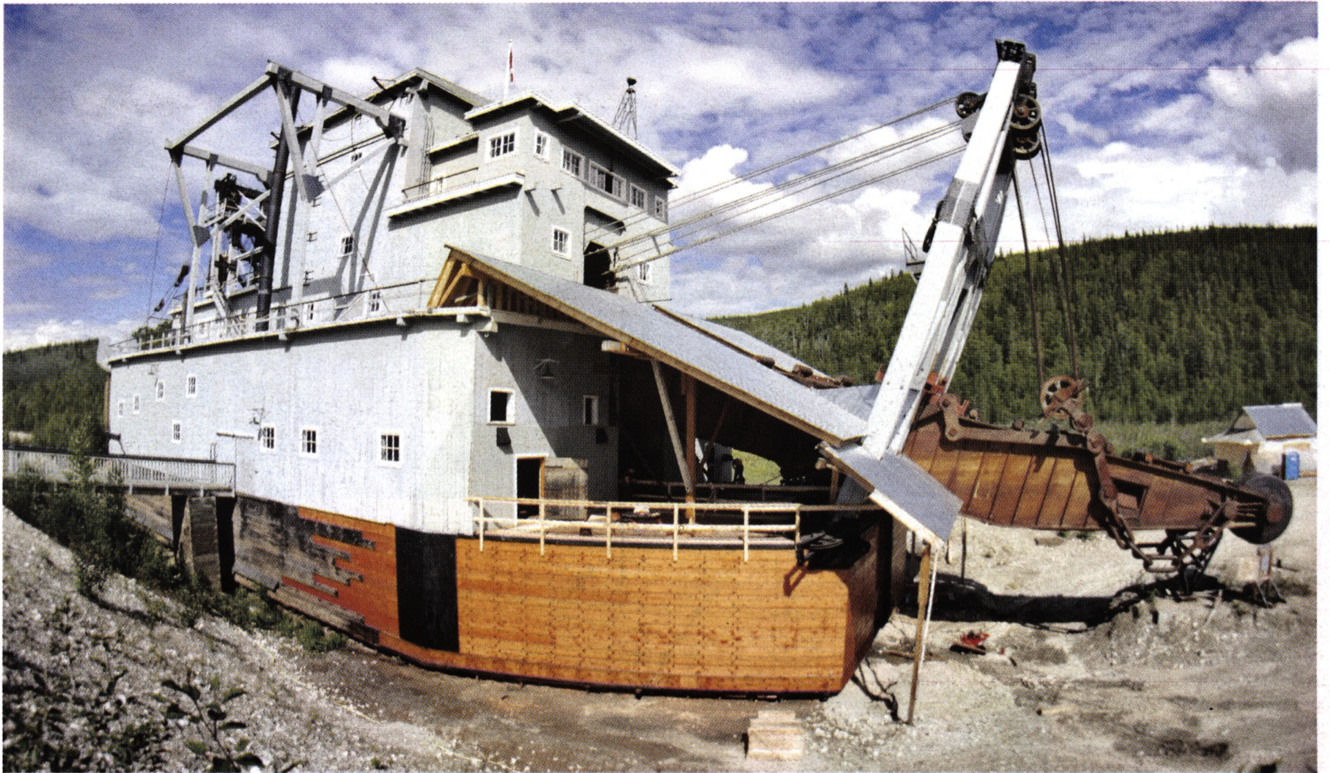
L'avant de la drague n° 4, en restauration depuis 2010. Les travaux à l'arrière de la drague devraient commencer en 2018.
