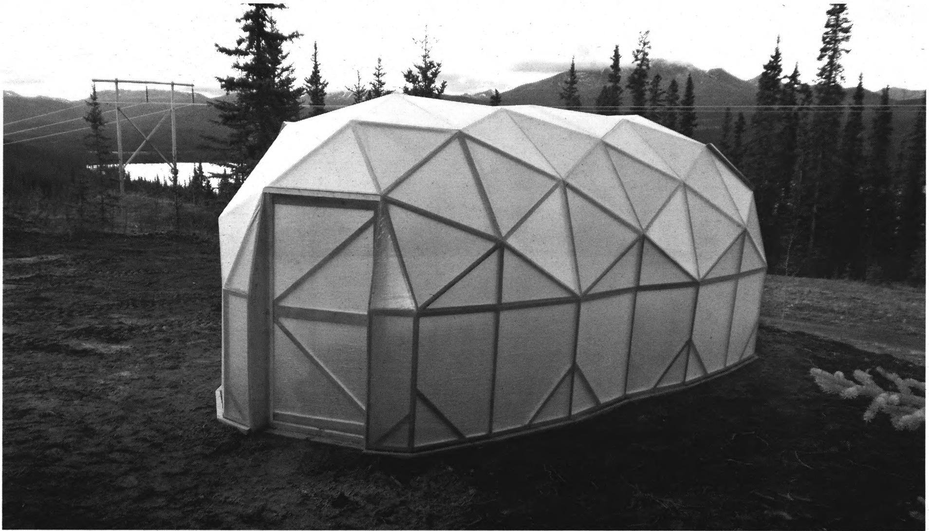
La serre thermodynamique fonctionne à l'énergie solaire et peut être complètement automatisée.
