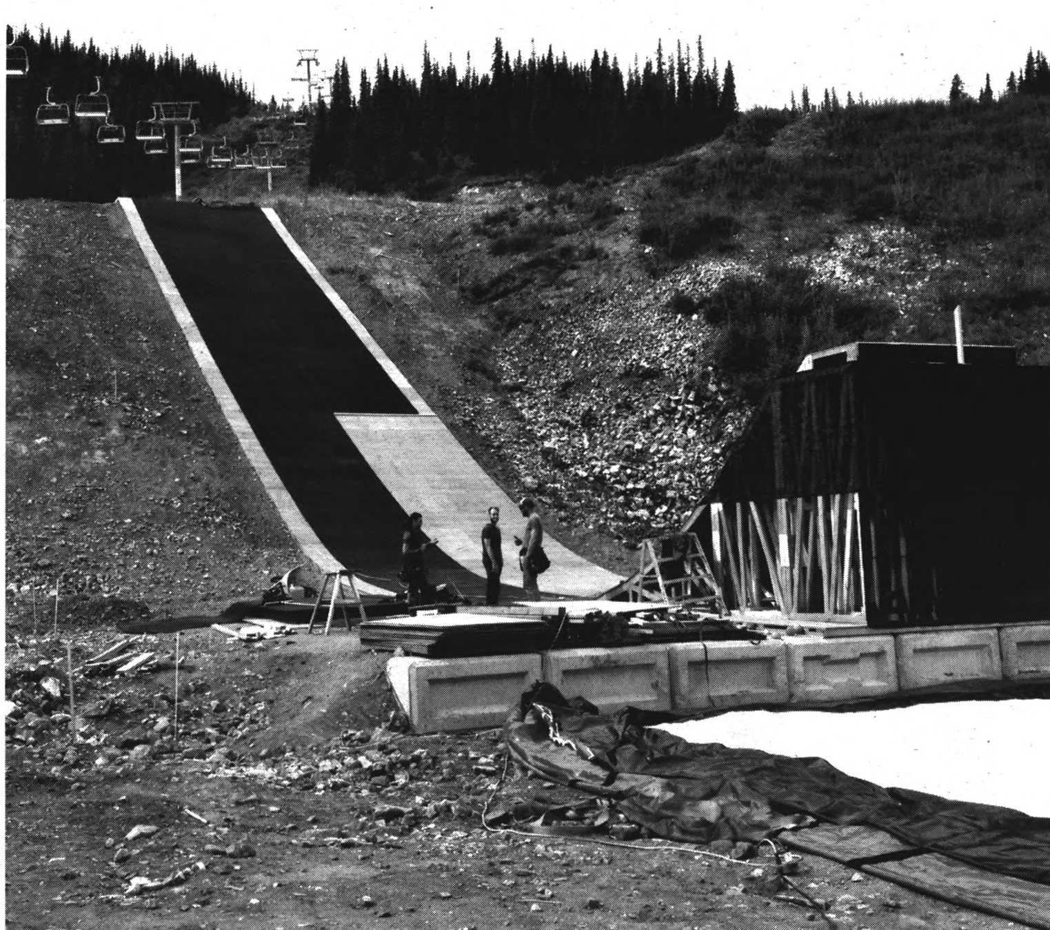
La nouvelle rampe du Mont Sima permettra aux skieurs acrobatiques de s'entraîner toute l'année.
