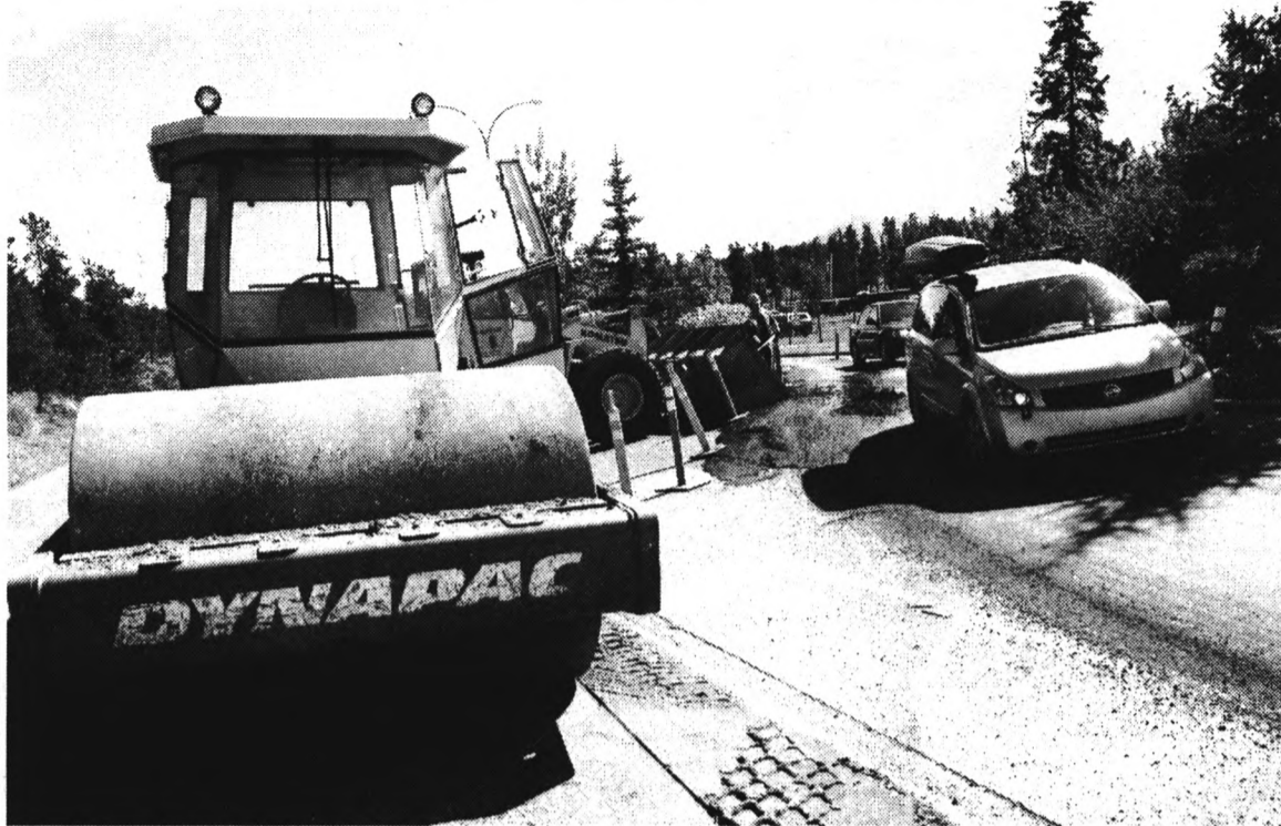
Les travaux de construction de l'école F.-H.-Collins vont bon train à Riverdale. Photo : Thibaut Rondel
