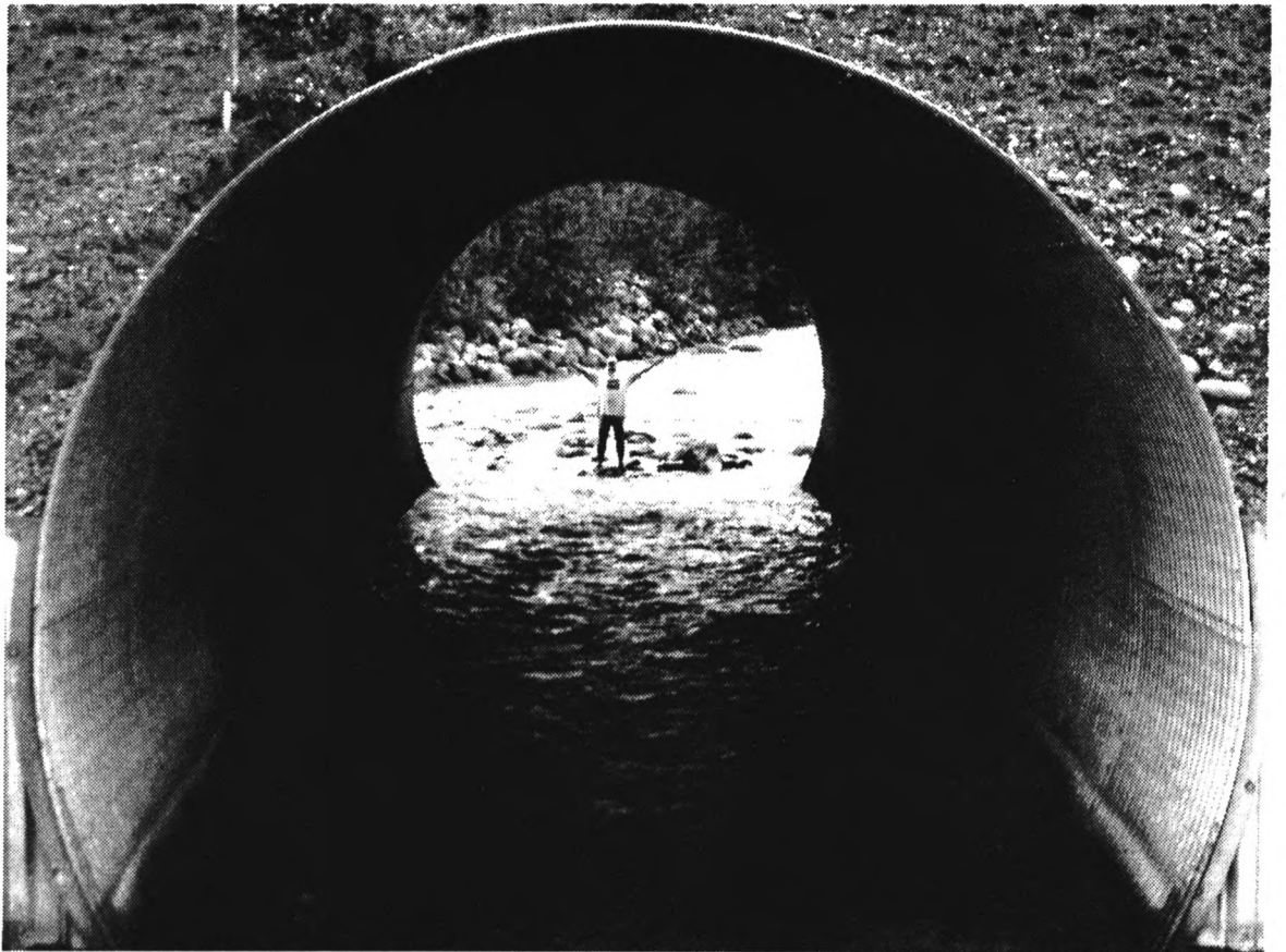
Le ruisseau Spencer sous la route de l'Alaska Photo de Benoit Latour
