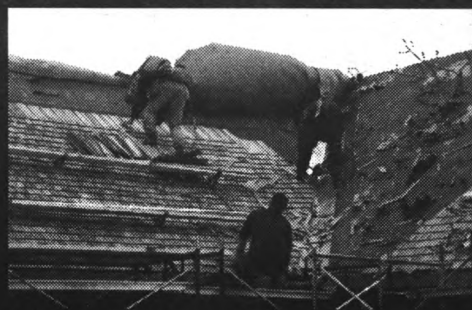
Réfection du toit de la vieille église en rondins (photo : gouvernement du Yukon)
