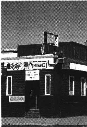
L'édifice sera démoli dans les mois qui viennent.
