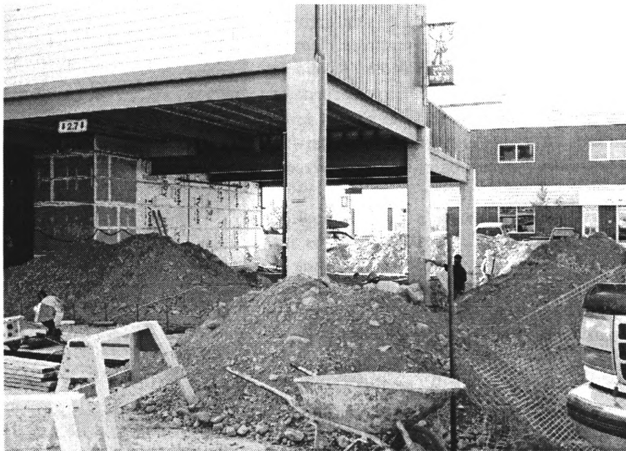
Les travaux vont de l'avant au Centre de la francophonie
