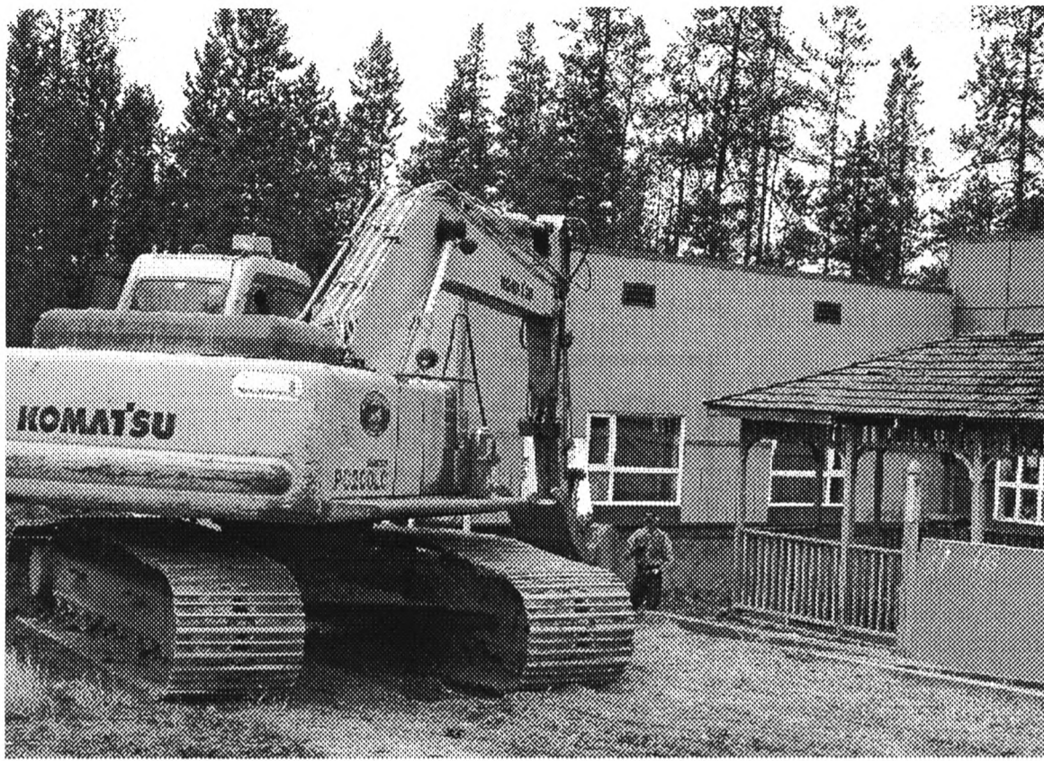
Les travaux d'agrandissement de la garderie vont bon train.
