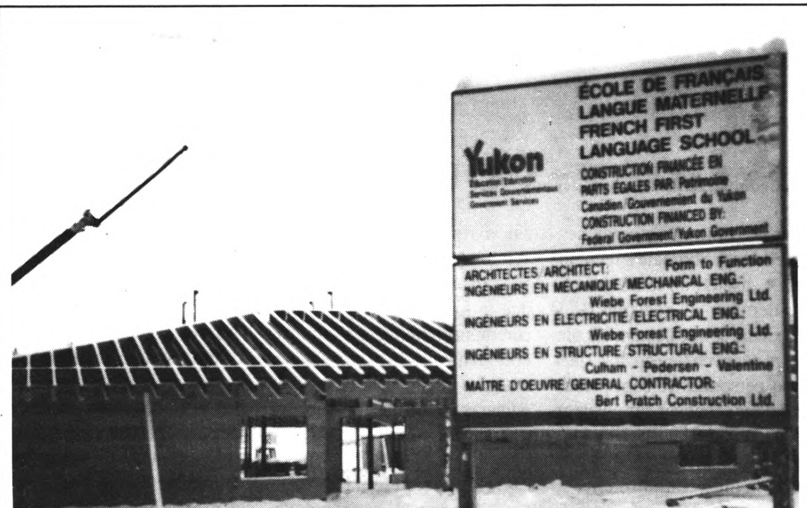
La construction de la nouvelle école va bon train malgré les froids antarctiques des dernières semaines.
