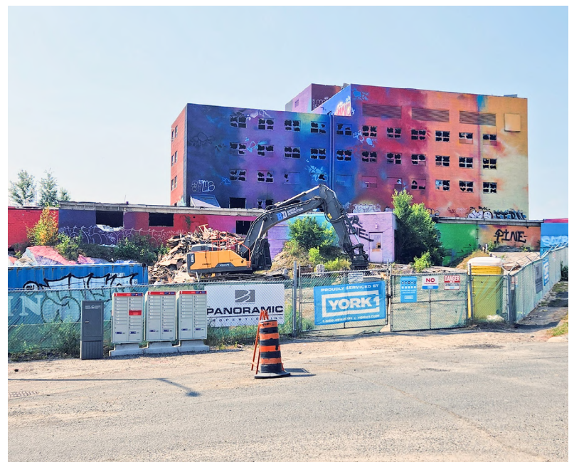
L'équipement lourd pour la démolition est déjà sur place. Photo : Donald Dennie
