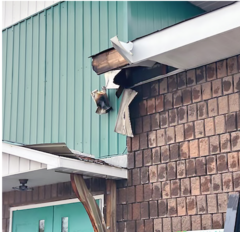
La chute du poteau électrique a occasionné des dégâts à plusieurs niveaux.
