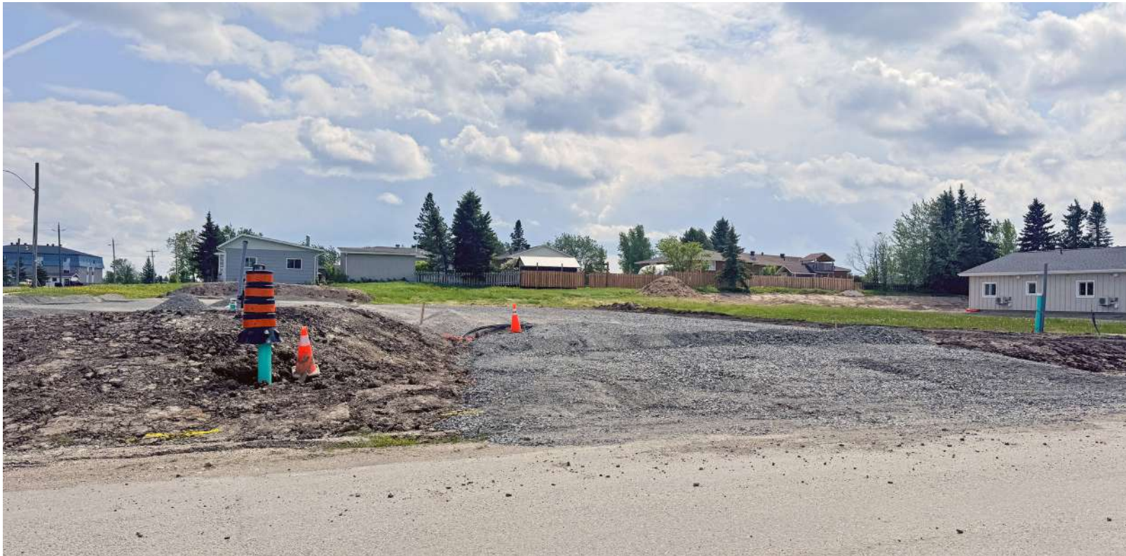
Chantier de Martin Boucher. Photo : Renée-Pier Fontaine
