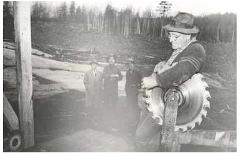
Un Goulard sur la chantier. Photos : Site internet Goulard Lumber.
