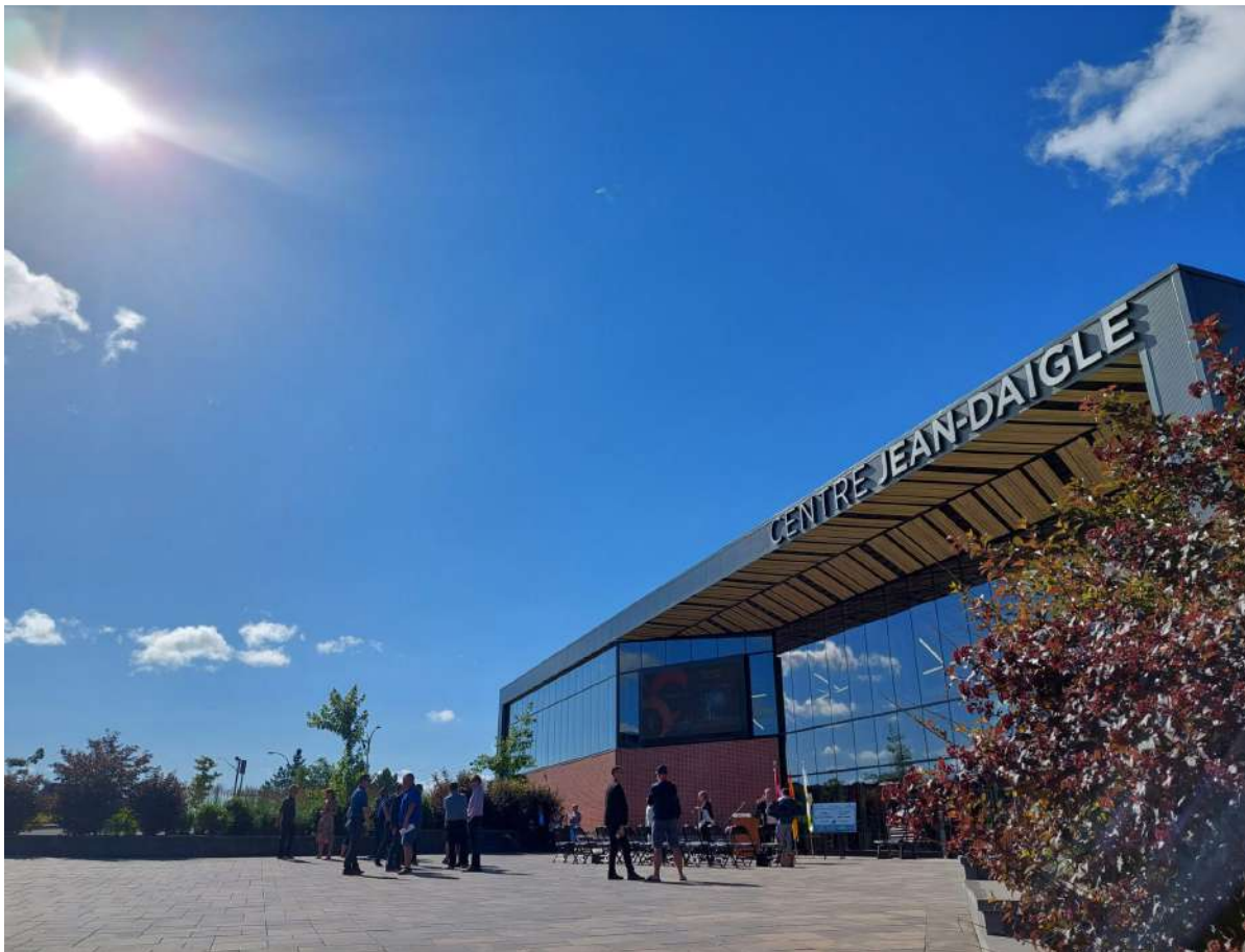
Les panneaux solaires installés sur le toit du Centre Jean-Daigle et du Pavillon sportif d'Edmundston seront fonctionnels au cours de l'été 2025. Photo : Archives
