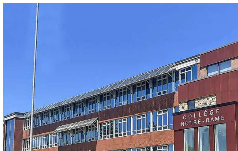
Le Collège Notre-Dame de Sudbury (CSC Nouvelon) est équipé de panneaux solaires réduisant l'énergie consommée (Photo courtoisie)
