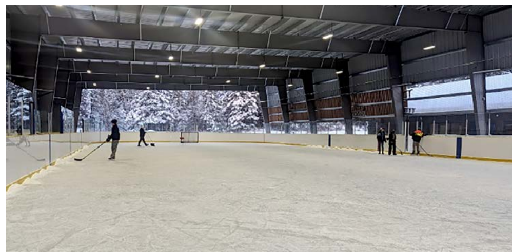
Le nouveau toit surélevé de la patinoire de Field.
