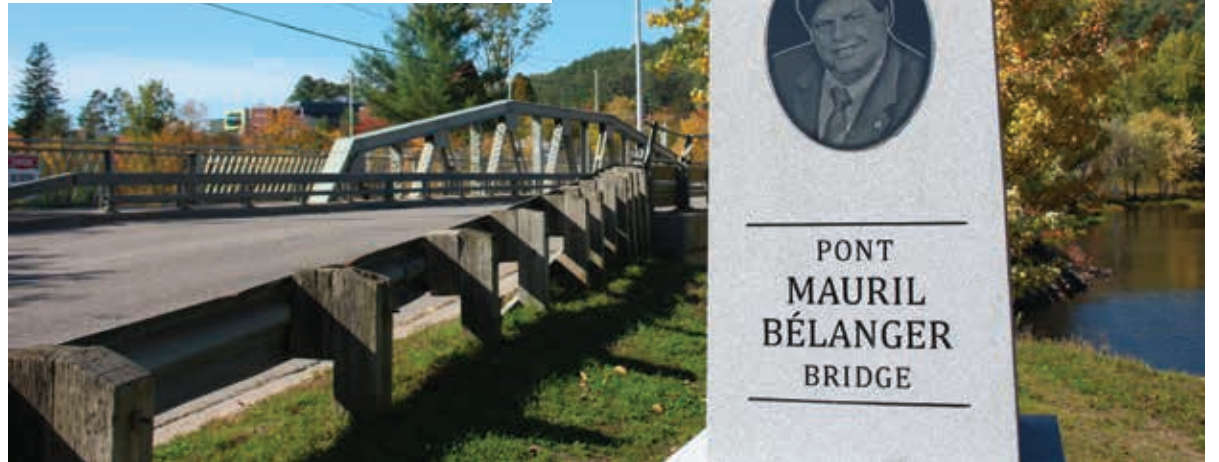
Le pont Mauril-Bélanger à Mattawa — Photos : Archives
