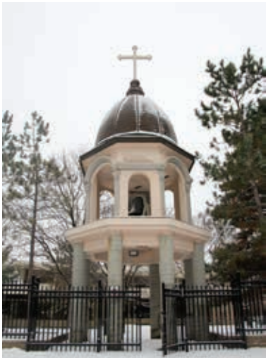
La nouvelle clôture qui cerce le terrain de la paroisse Ste-Anne-des-Pins au centre-ville de Sudbury. — Photos : Julien Cayouette
