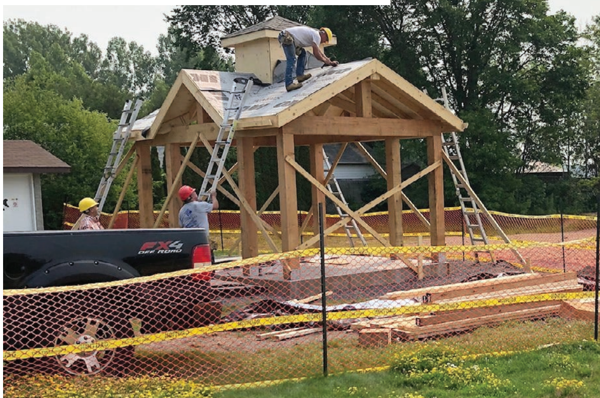
Le pavillon en construction — Photos : Courtoisie Club Rotary de Blind River
