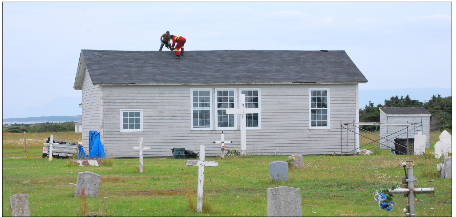
Larry Felix et Ivan Jesso ont remplacé les bardeaux du toit de l'ancienne école au cours de l'été. Photo: Cody Broderick
