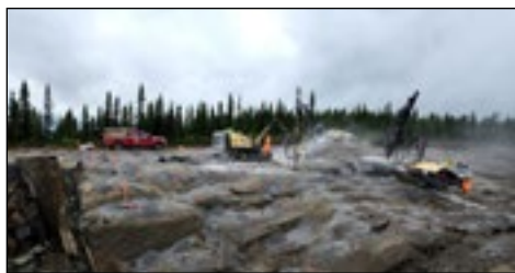
Après le décapage du roc qui consiste à en retirer le sol et la végétation, celui-ci est nettoyé à l'aide d'un jet d'eau sous pression afin de permettre de le forer et de le dynamiter par la suite. Photo: Courtoisie (MTMD)
