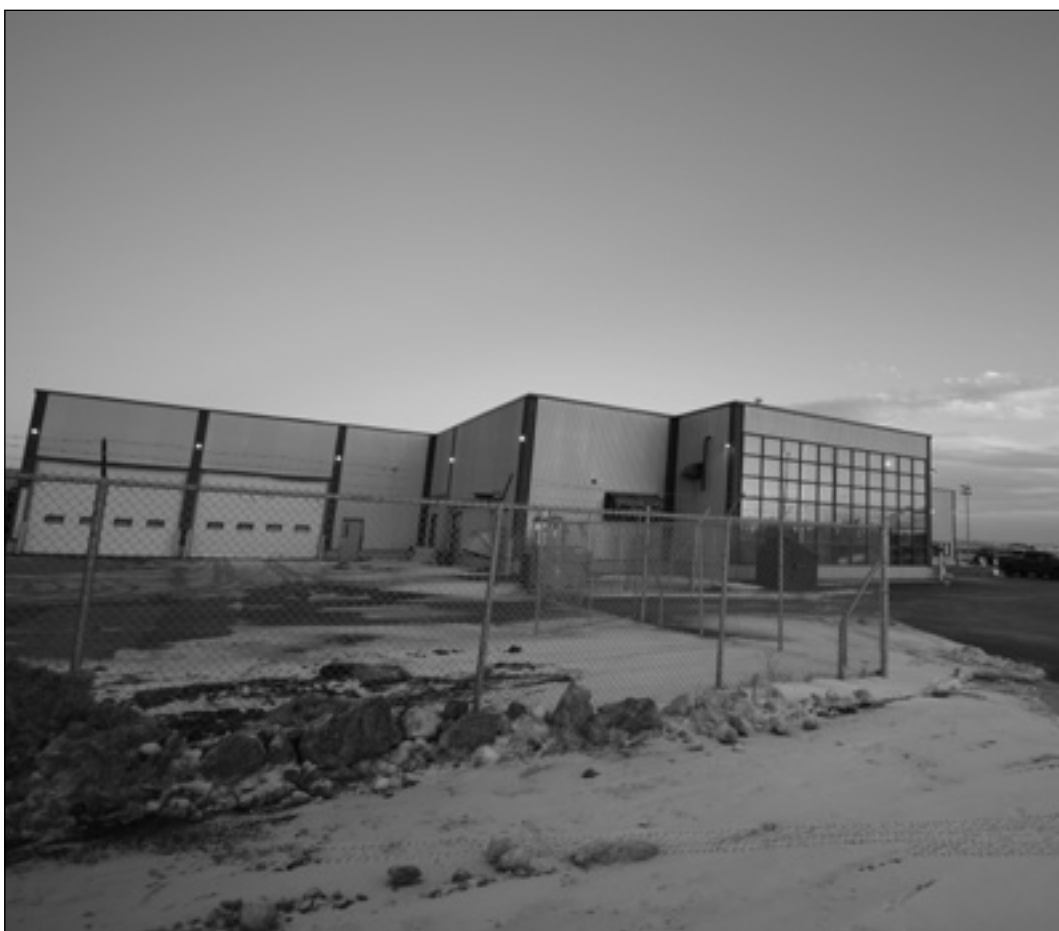
Sur la photo, l'ancienne caserne des pompiers aéroportuaires de Transports Canada adjacente à l'aéroport de Wabush reprendra du service à compter de l'an prochain. Photo: Éric Cyr (Le Trait d'Union du Nord)
