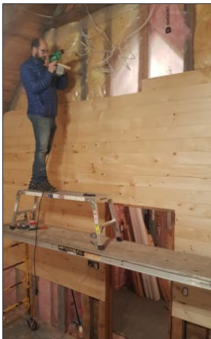
Après sa journée de télétravail, Yves se met...au travail de rénovation pour avancer sur les branchements pour l'électricité: «Le travail pour l'électricité a été fait en majorité par nous deux, tout devait être finalisé rapidement pour fermer les murs.»
