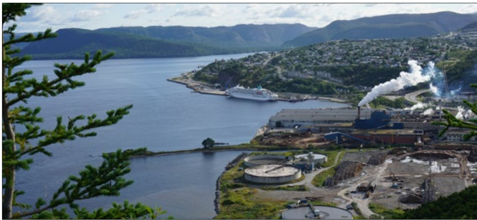
Photo : Courtoisie de la Corporation du port de Corner Brook
