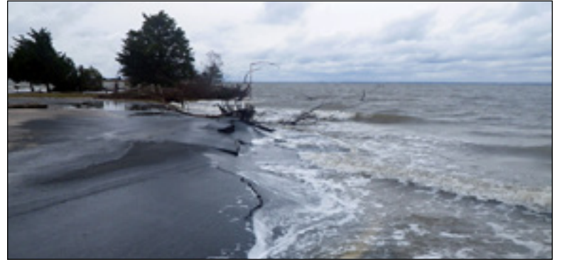
L'élévation du niveau des océans est un des impacts des changements climatiques.
