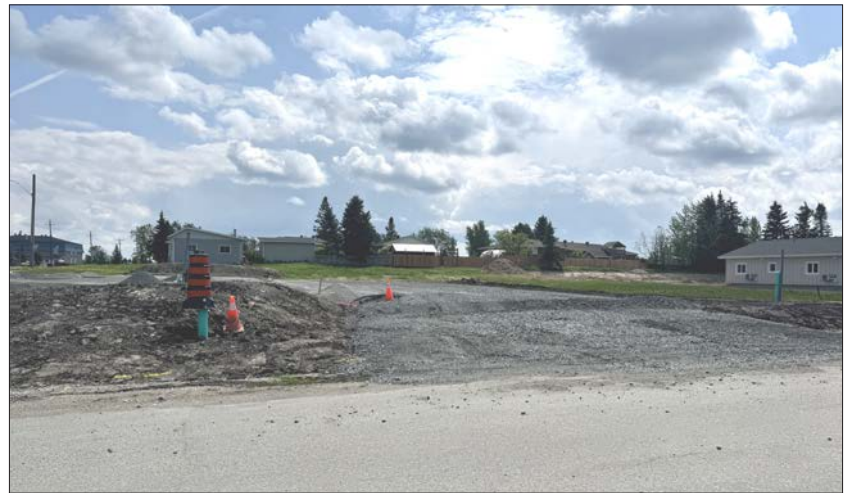
Le chantier de Martin Boucher progresse malgré le refus de financement du PAC Logement. Photo : Renée-Pier Fontaine
