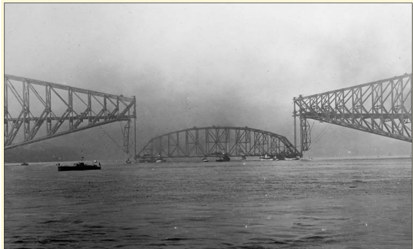
Élévation de la travée centrale juste avant l'effondrement - 1916 Bibliothèque et Archives Canada et St. Lawrence Bridge Company
