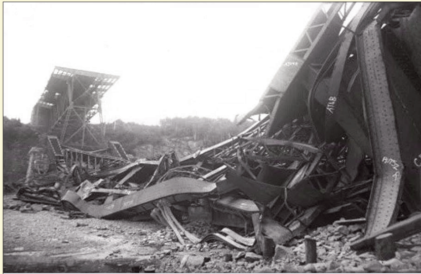
Effondrement du pont de Québec - 1907 Bibliothèque et Archives Canada et St. Lawrence Bridge Company
