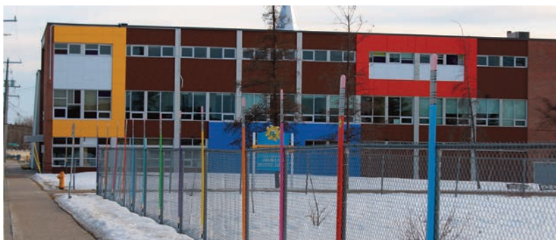
La direction de l'Université de Hearst a investi beaucoup d'argent pour la structure extérieure et dans le gymnase. Au cours des prochains mois, ce sont les deuxième et troisième étages qui seront touchés par des rénovations d'une valeur de trois-millions de dollars. Photo/LeNord
