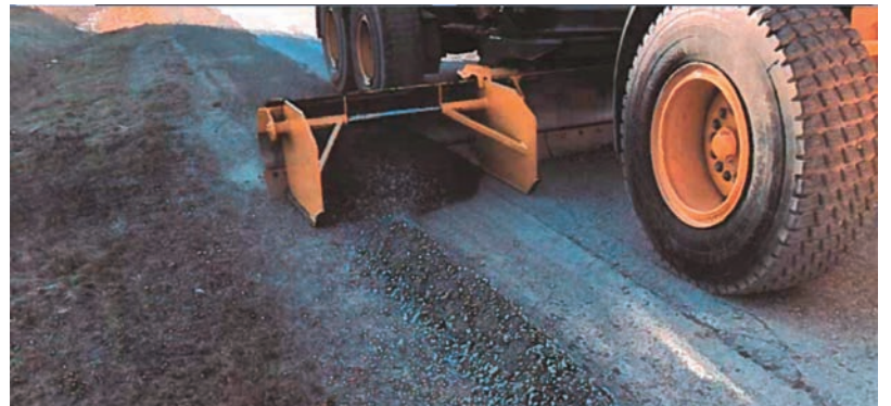
Cette pièce a été créée par l'équipe des travaux publics de la Ville de Hearst pour faciliter la réparation des bordures de routes en gravelle. Photo : Ville de Hearst
