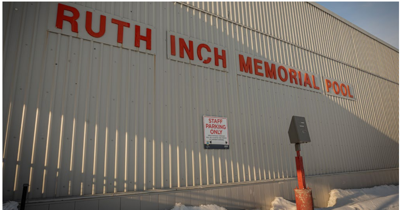
Fermé depuis environ un an, l'ancien bâtiment de la piscine Ruth Inch Memorial attend sa reconversion. Une proposition en discussion suggère d'y aménager des espaces pour la création et la pratique des arts de la scène. (Photo Cristiano Pereira)
