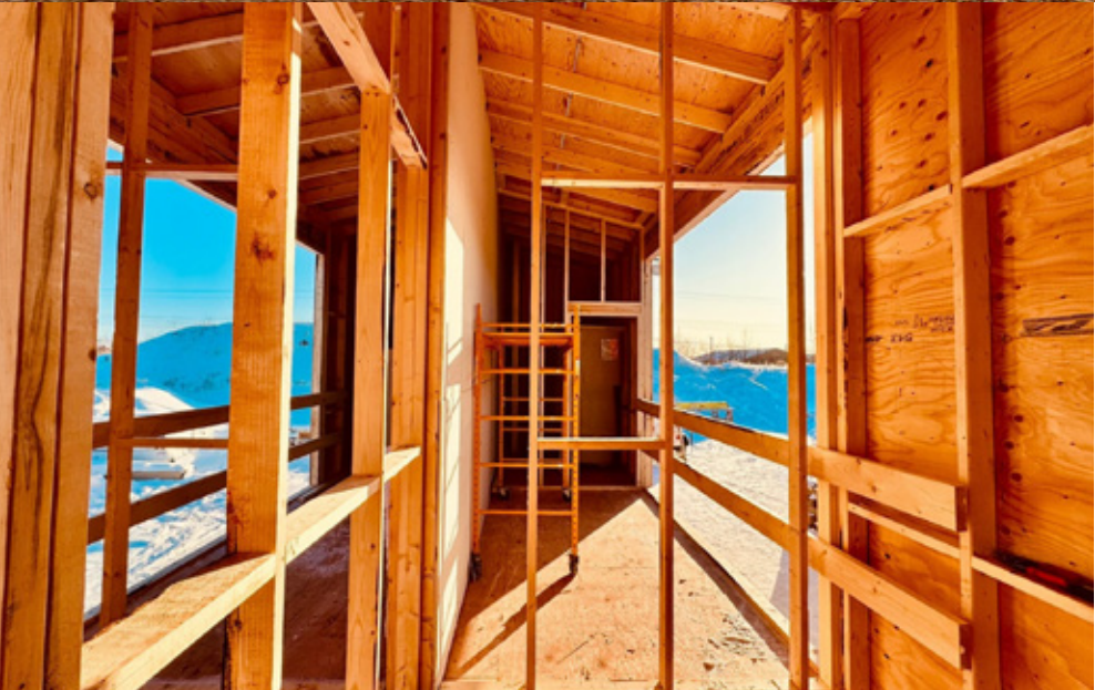
(HAUT) AVANCÉES DU PROJET DE CONSTRUCTION HYBRIDE DE DÉLÎNĚ
