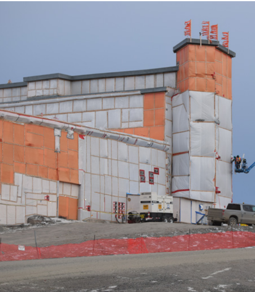
Une des nombreuses bâtisses de la mine Giant, prochainement vouée à être mise à terre. (Photo Élodie Roy)
